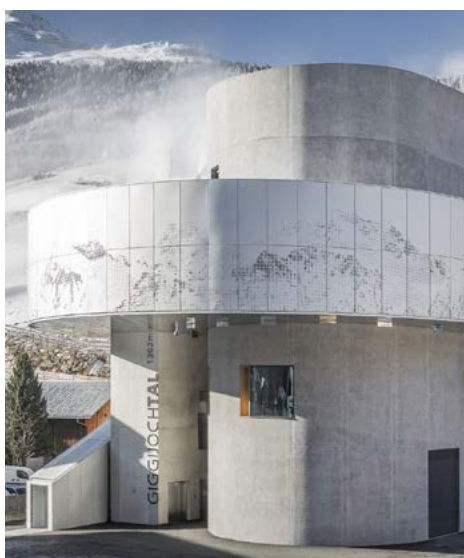
Giggijochbahn Talstation | Sölden
